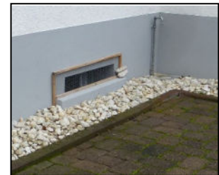
Abbildung 07: Beispiele von Objektschutzmaßnahmen (Überbogen, Geländemodellierungen, Aufkantung am Kellerfenster)
