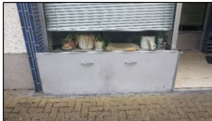
Abbildung 06: Beispiele von Objektschutzmaßnahmen (mobile Steckelemente, Dammbalkensysteme, Abdichtungen)
