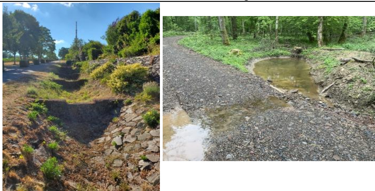
Beispiele (RF) - links: kaskadenförmiger Graben; rechts: Kleinstrückhalt im Wald
