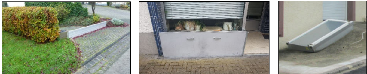
Abbildung 07: Beispiele von Objektschutzmaßnahmen (mobile Steckelemente, Dammbalkensysteme, Abdichtungen)
