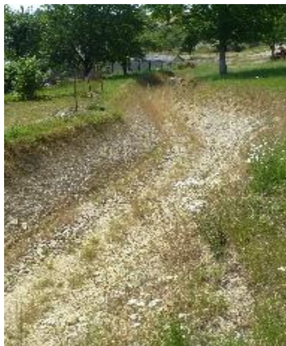
Visualisierung Maßnahmenvorschlag N (Mulde als Notabflussweg)
