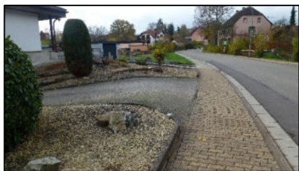
Abbildung 07: Beispiele von Objektschutzmaßnahmen (Überbogen, Geländemodellierungen, Aufkantung am Kellerfenster)
