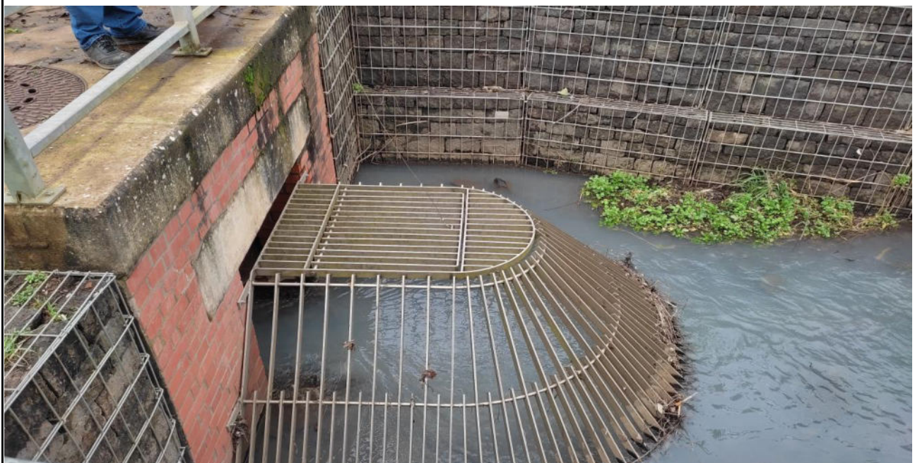
Beispielbild Maßnahmenvorschlag (tO)
