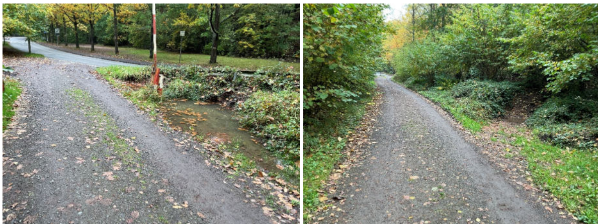
Abbildung 08: Positivbeispiele wegebegleitende Kleinstrückhalte im Forst (BG 5 – „Biertal“)
