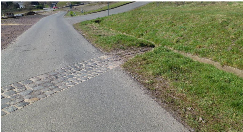
Beispiel Maßnahmenvorschlag (RF)
