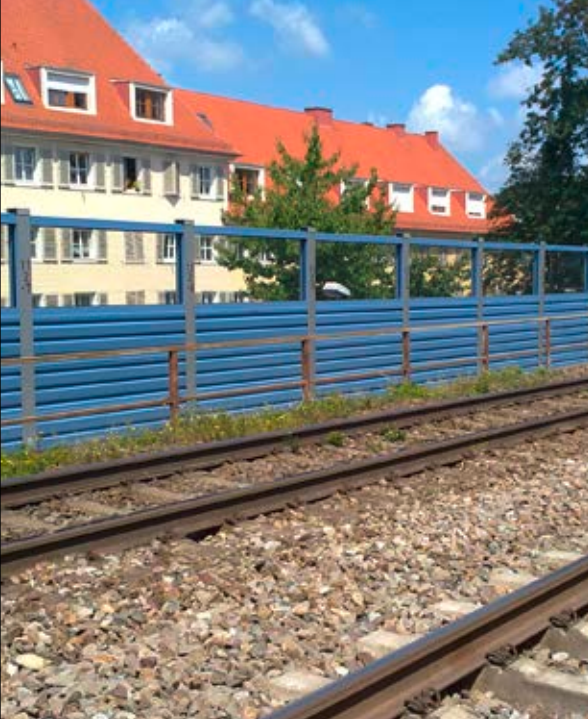
Schallschutzwände mit durchsichtigen Elementen...
