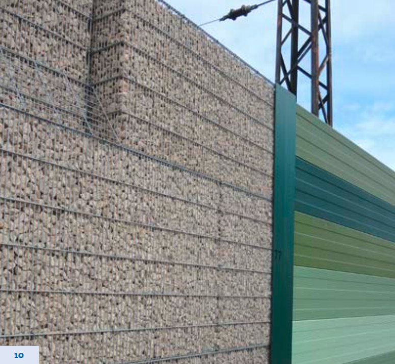
Schallschutzwände aus Drahtgabionen...
