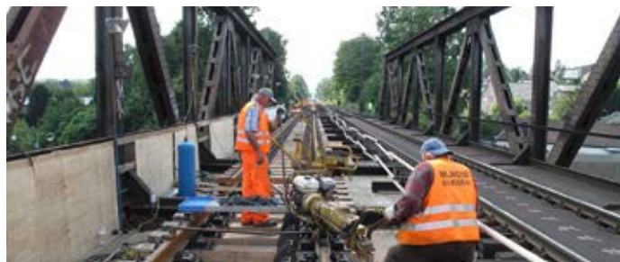
Entdröhnung einer Brücke in Herzogenrath
