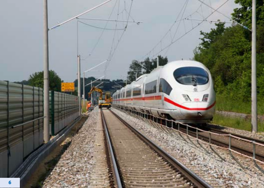
Schallschutzwände zählen zu den aktiven Maßnahmen der Lärmsanierung
