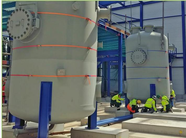
Abbildung: Elektrodenheizkessel einer Power-to-Heat-Anlage
