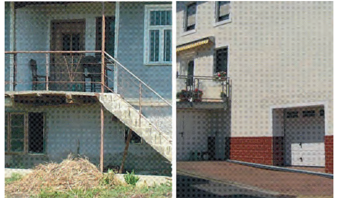
Angepasste Bauweise: erhöhter Hauseingang (Fotos: An-negret Thieken/ GFZ Potsdam, alpS GmbH)
