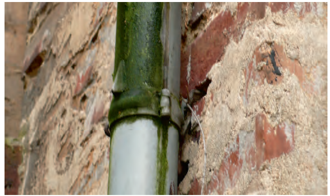
Beschädigtes Fallrohr (Foto: Fritz Hatzfeld/ Hydrotec GmbH)
