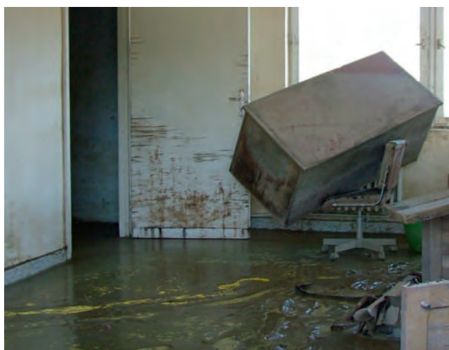
Hochwasserschäden an Türen und Wänden (Foto: Anne-gret Thieken/ GFZ Potsdam, alpS GmbH)
