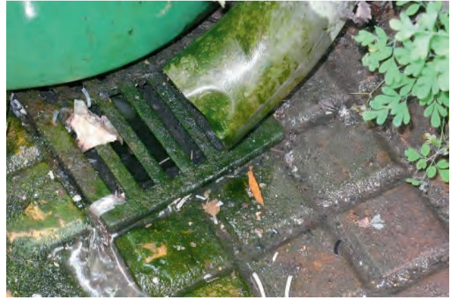
Hofeinlauf (Foto: Fritz Hatzfeld/ Hydrotec GmbH)
