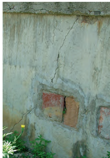
Bauwerkschaden durch Setzung (Foto: Annegret Thieken/GFZ Potsdam, alpS GmbH)
