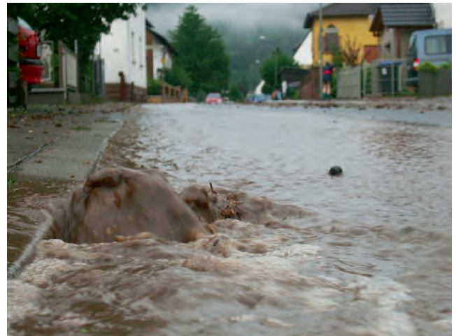
Überflutung des Straßenraumes durch Überlastung der Mischwasserkanalisation während dem Ereignis vom 22.07.2006 in Mölschbach (Foto: K.-H. Gasiorek)
