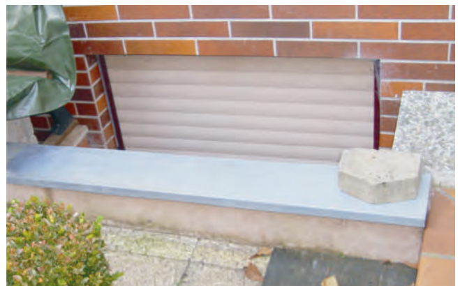
Permanente Erhöhung des Überflutungsschutzes eines Lichtschachts (Foto: Daniel Hammen)
