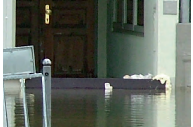
Hochwasserschutz am Haus – mobile Schotten (Foto: Ulrich Herrmann/GFZ Potsdam)
