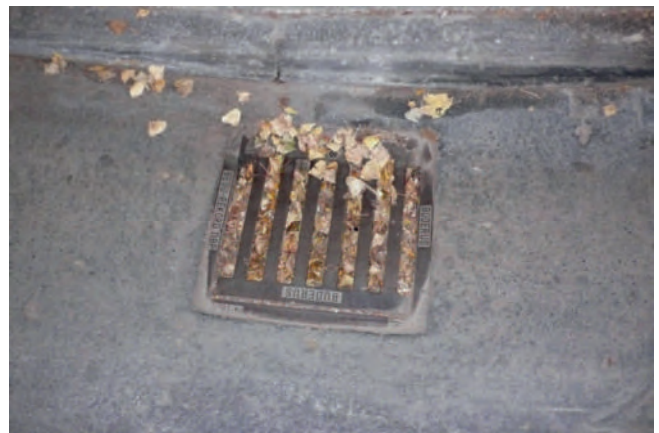
Verstopfter Gully (Foto: Fritz Hatzfeld/ Hydrotec GmbH)
