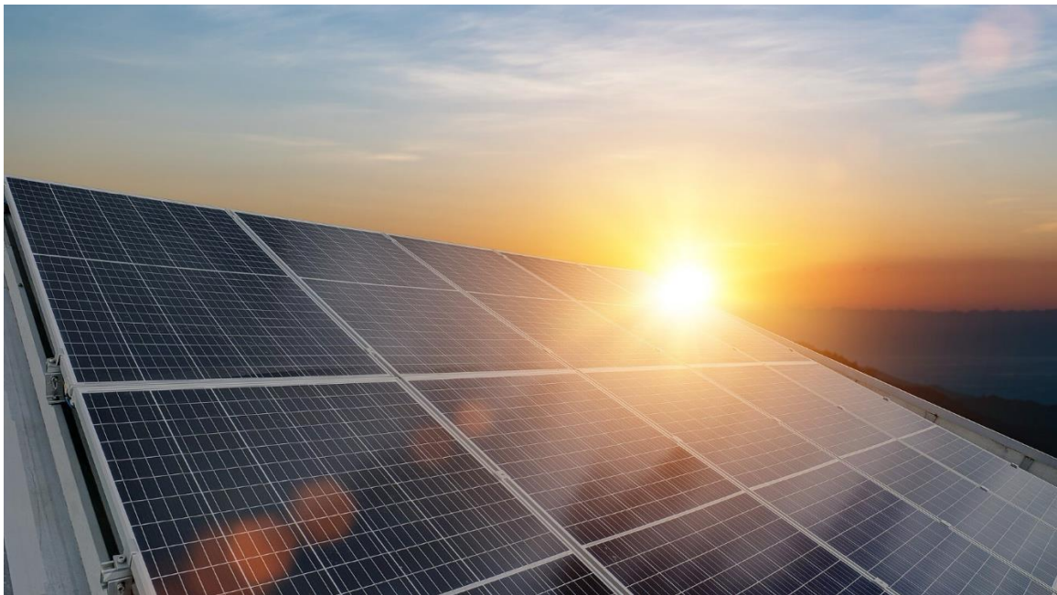
Abbildung 16 - Sonnenuntergang hinter einer Modulreihe - Quelle: https://www.innotech-safety.com/fileadmin/_processed_/c/4/csm_5_Tipps_rund_um_Ihre_PV-Anlage_am_Dach-Header_356649df9b.jpg
