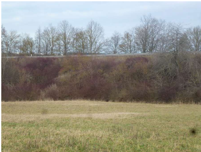
Abb. 9: Straßenböschung im nördlichen verbuschten Bereich
