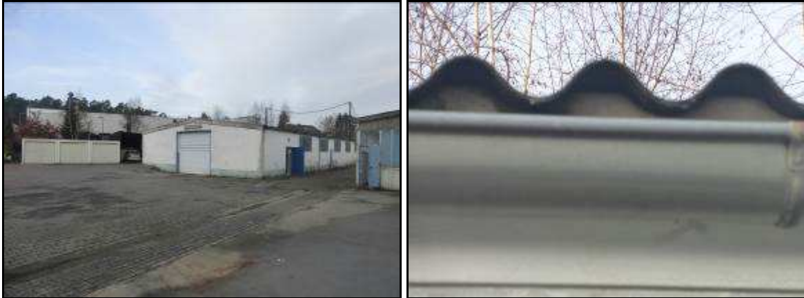
Abb. 4 und 5: Sicht auf das westliche Betriebsgebäude und auf die Wellplatten
