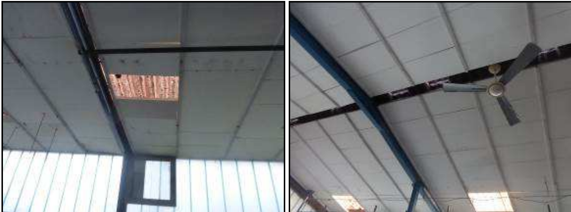
Abb. 8 und 9: Sicht auf die Dachflächen im östlichen Gebäude
