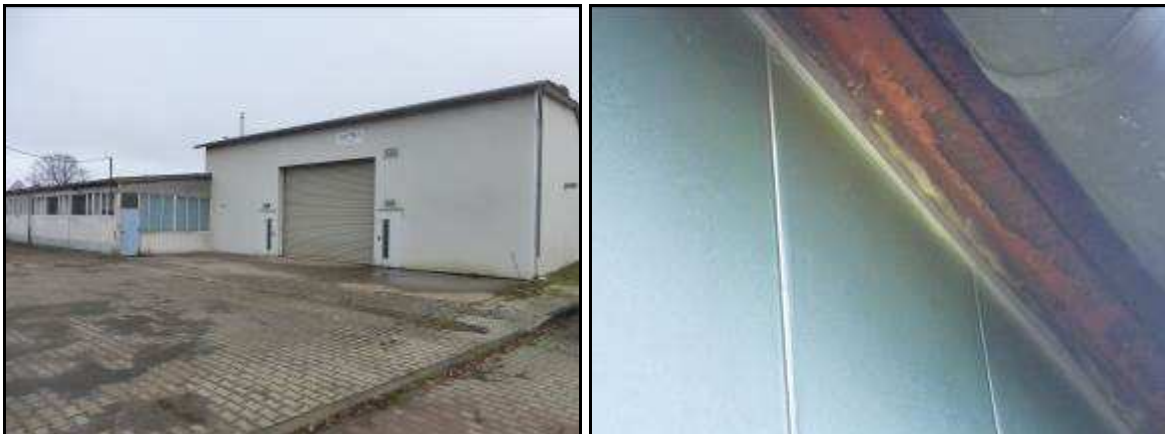
Abb. 6 und 7: Sicht auf das Werkgebäude und Werkhalle und auf die Dachtraufe
