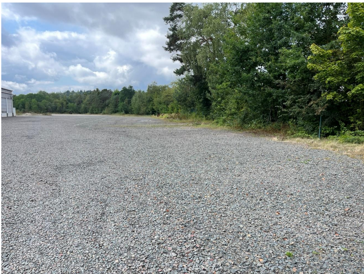
Abbildung 3-4: Gelände nach Abtransport der Müllstrukturen (Foto: BG Natur, 09/2024)
