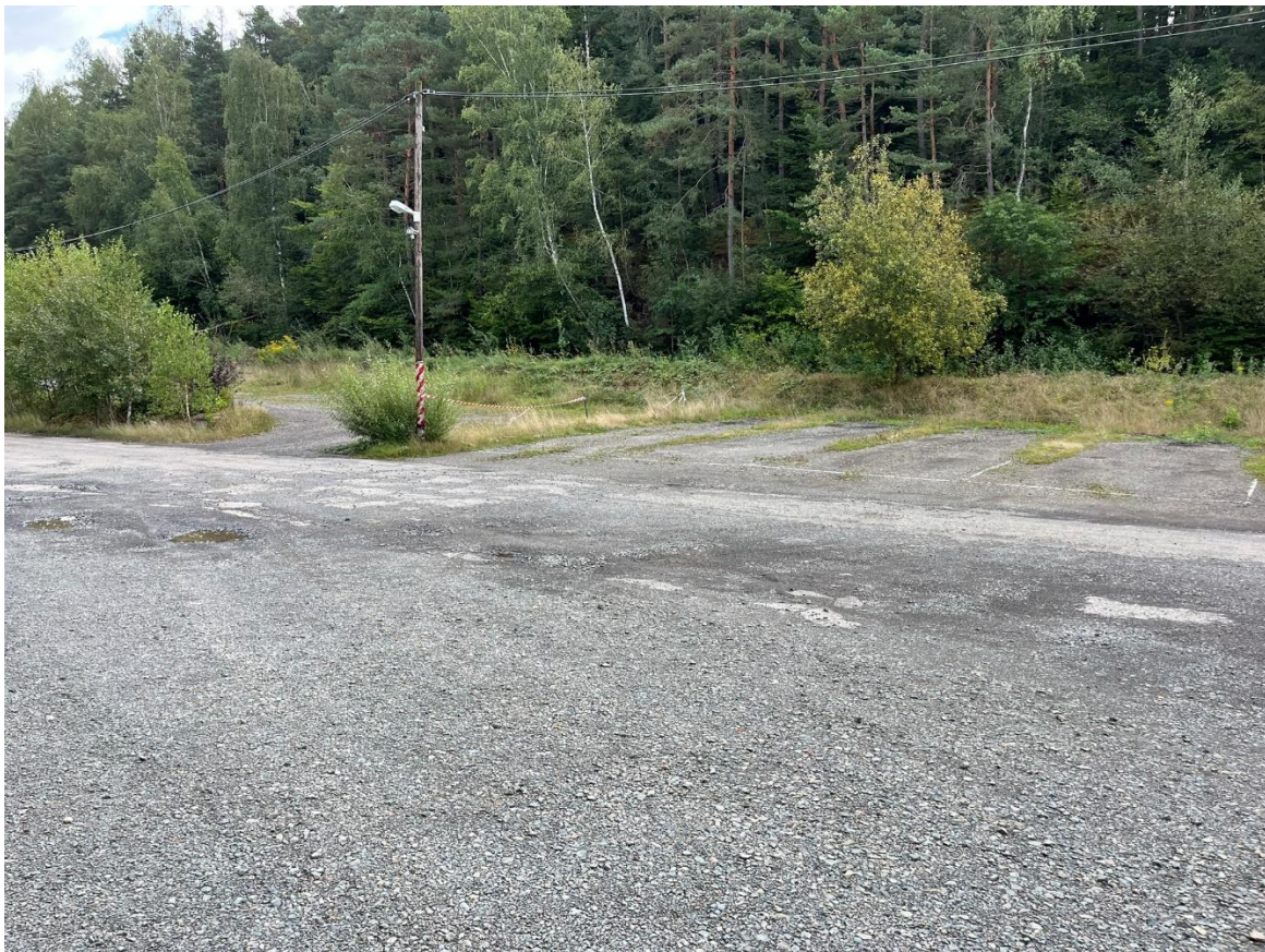
Abbildung 1-2: Gelände nach Abtransport der Müllstrukturen (Foto: BG Natur, 09/2024)
