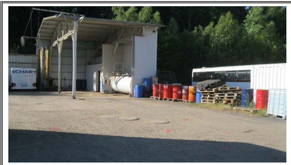
Foto 2: Untersuchungsfläche, Tankstellenbereich und Schächte Sandfang/Ölabscheider
