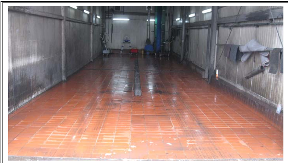
Foto 8: Waschhalle für Omnibusse, westlicher Teil der Wartungshalle
