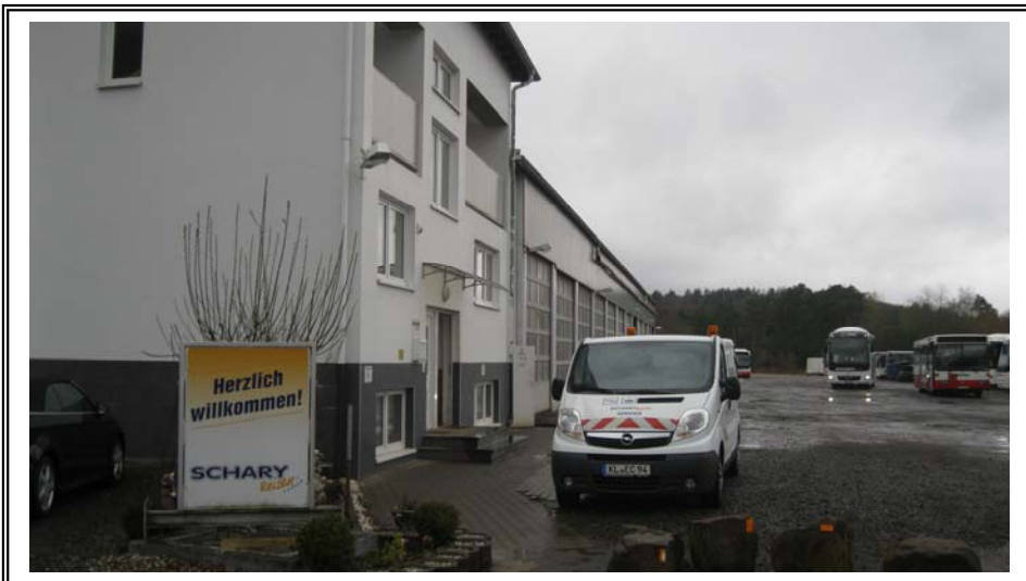
Foto 6: Blick auf das Bürogebäude und die Wartungshalle für Omnibusse, Blickrichtung nach Westen
