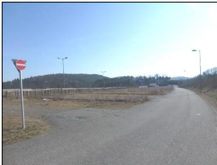
Abb. 4: Sicht auf die innere Zuwegung und Parkplatzfläche mitsamt Erdwall an der A6
