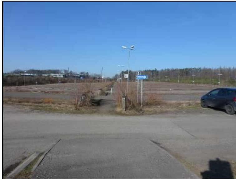
Abb. 3: Sicht auf das Parkplatzgelände von Osten nach Westen
