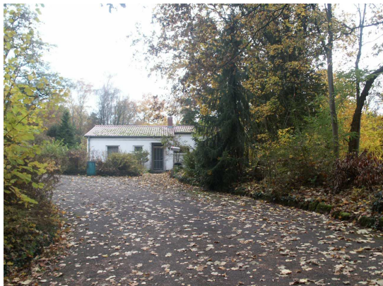
Bestehendes Wohnhaus, Bremerstraße 27 (Erhalt des Gebäudes)
