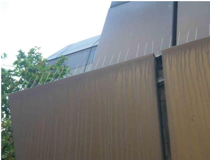
Abbildung 4 Blick auf die glattwandige Blechverkleidung der Außenfassade des ehem. Karstadt-Gebäudes mit Schutzvorrichtung gegen Straßentauben
