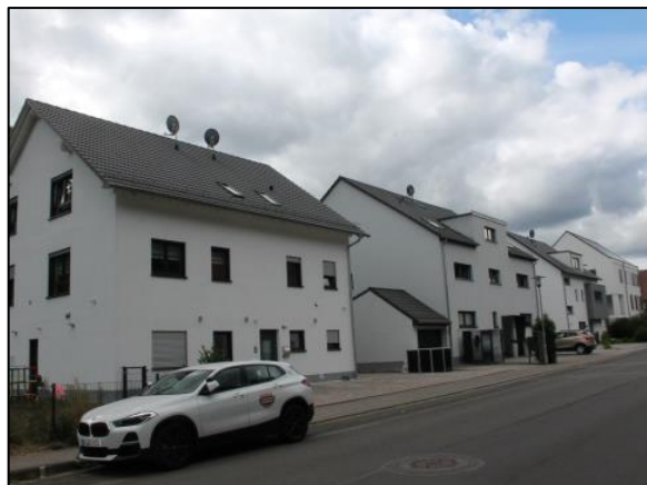
Baulicher Bestand in der Straße „Im Dunkeltälchen“ (Hausnrn. 3, 3a, 5, 7, 7a und 9) (Südseite)
