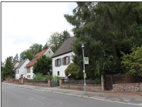
Baulicher Bestand in der Straße „Im Dunkeltälchen“ (Hausnrn. 2, 4 und 6)
