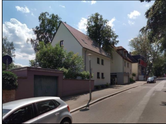
Baulicher Bestand in der Kurpfalzstraße (Hausnrn. 9, 11 und 13) (Westseite)
