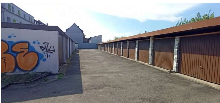
Abbildung 9: Blick auf den Garagenhof
