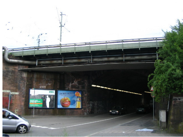
Abb. 2: Ansicht von Norden mit Stahlüberbau Gleis 228
