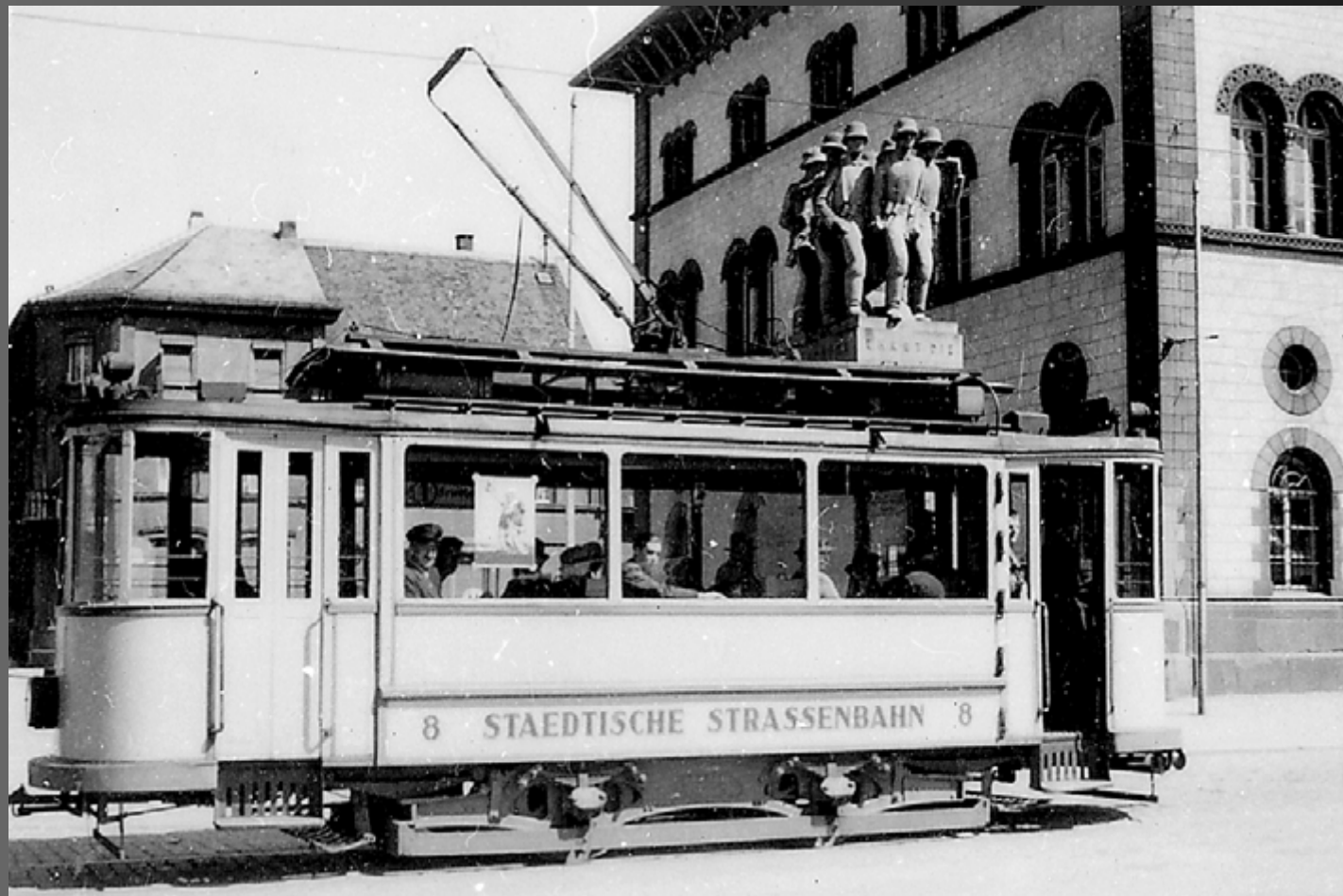
1935: Die „Elektrische“ passiert das 23er-Denkmal und die Fruchthalle
