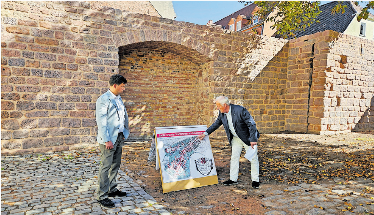
Baudezernent Manuel Steinbrenner und Klaus Meckler vor der neu sanierten Stadtmauer. Klaus Meckler erläutert das Vorgehen bei der Projektplanung.
