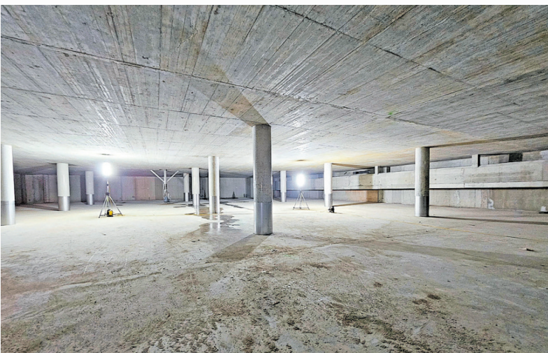
Das riesige Becken hat die Anmutung einer Tiefgarage
