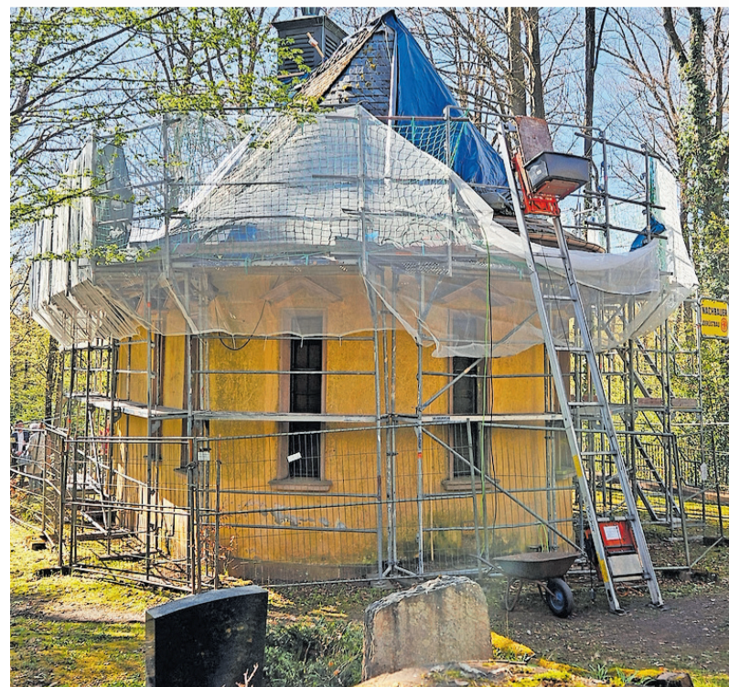
Das Gerüst um die Kapelle steht und die Arbeiten am Dach haben begonnen. FOTO: PS
