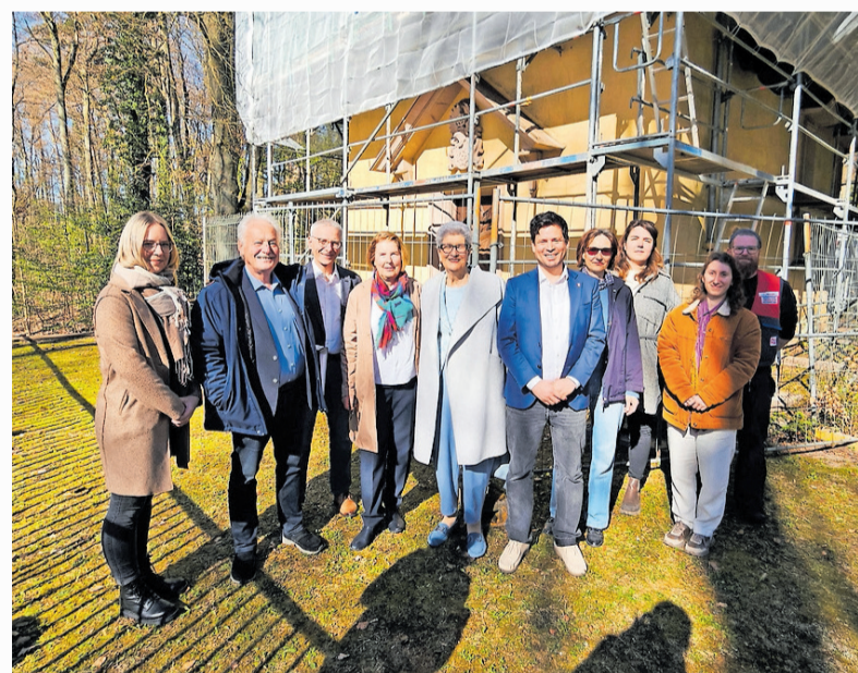
Beigeordneter Manuel Steinbrenner (5.v.r.), Karin Kolb (5.v.l.) und Renate Willkomm (4.v.l.) besichtigten gemeinsam mit dem Referat Gebäudewirtschaft, der Generaldirektion Kulturelles Erbe Rheinland-Pfalz, dem Architekturbüro Meckler+Partner sowie der Dachdeckerei Hehrlein die beginnenden Sanierungsarbeiten an der Huberkapelle. FOTO: PS
