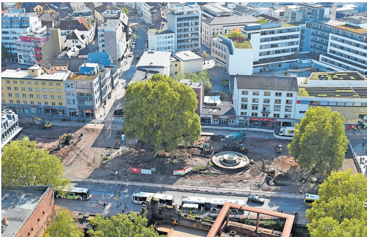
Seit einigen Wochen sind die Arbeiten in der Stadtmitte in vollem Gange. Unter anderem wurden die Wurzeln der Stadtplatane mit einem Saugbagger freigelegt und dann mit neuem Substrat bedeckt. Das Bild wurde am 17. Oktober aufgenommen.
