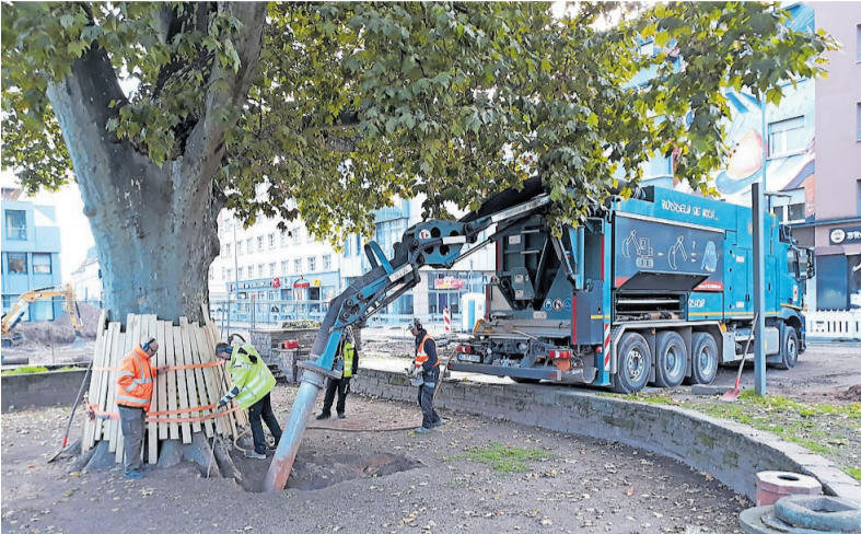
Der Saugbagger ist derzeit rund um die Stadtplatane im Einsatz
