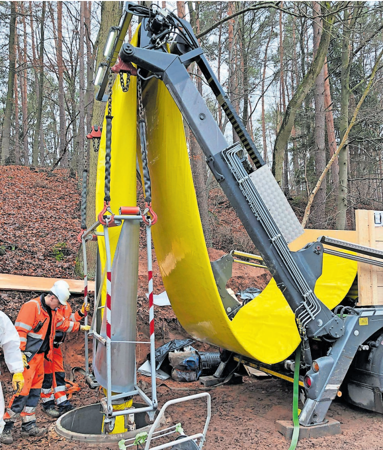
Beim sogenannten Schlauchlinerverfahren wird ein Spezialschlauch in das vorhandene Kanalrohr eingezogen und dann ausgehärtet.
