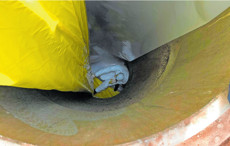
Beim sogenannten Schlauchlinerverfahren wird ein Spezialschlauch in das vorhandene Kanalrohr eingezogen und dann ausgehärtet.
