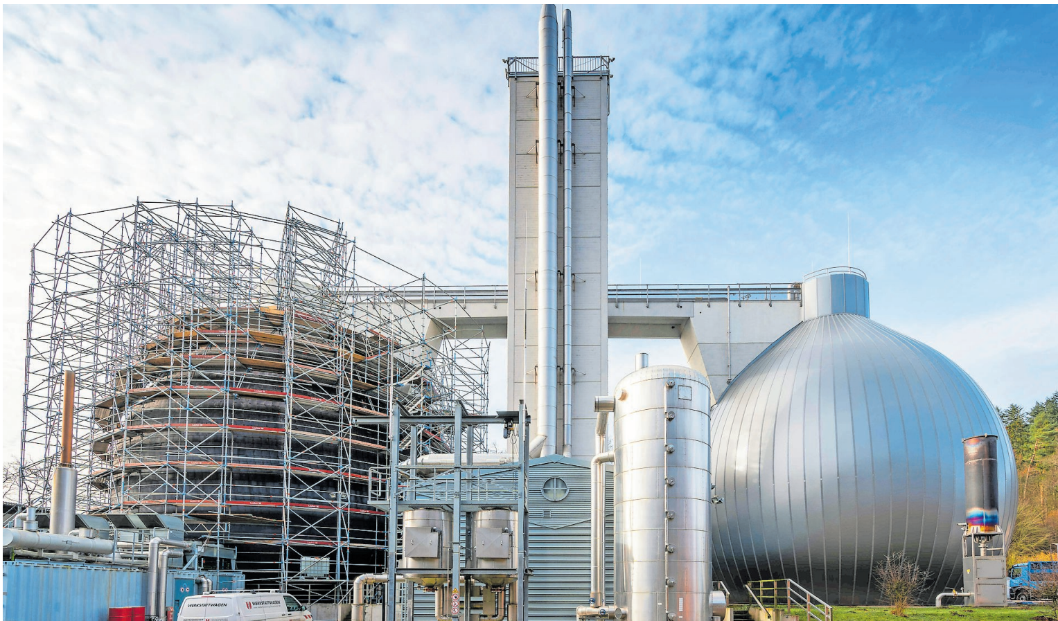
Die Hülle des ersten Behälters ist bereits erneuert, während am zweiten Behälter gerade das mächtige Montagegerüst errichtet wird
