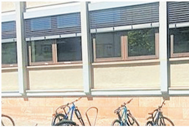
Die Fassade des Gymnasiums vor und nach der Reinigung
