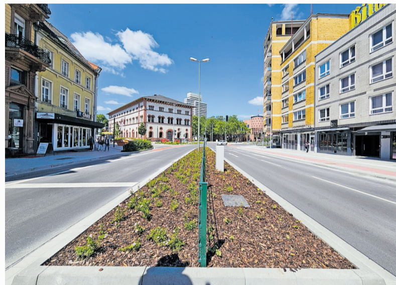
Am Montag war die Kreuzung komplett baustellenfrei
