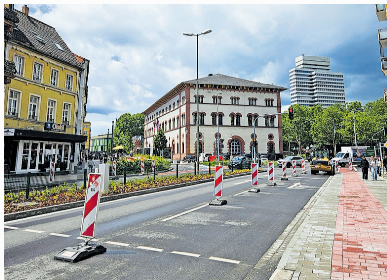
Letzte Woche fanden noch letzte Restarbeiten statt
