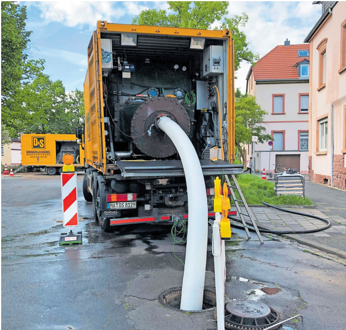
Einige der Kanäle müssen mit Schlauchlinern neu ausgekleidet werden
