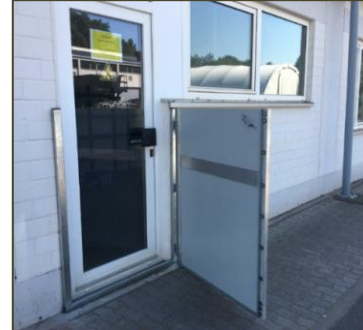
Bauliche Maßnahmen zum Hochwasserschutz Quelle: Stadtentwässerung Kaiserslautern AöR
