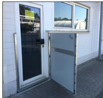
Bauliche Maßnahmen zum Hochwasserschutz Quelle: Stadtentwässerung Kaiserslautern AöR
