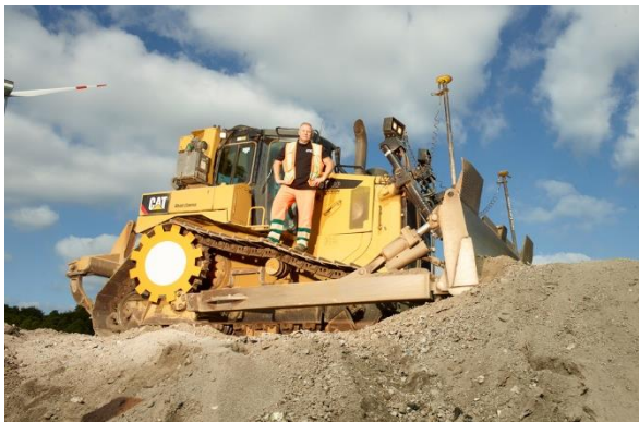
Abb.: Kettenraupe auf der Deponie
