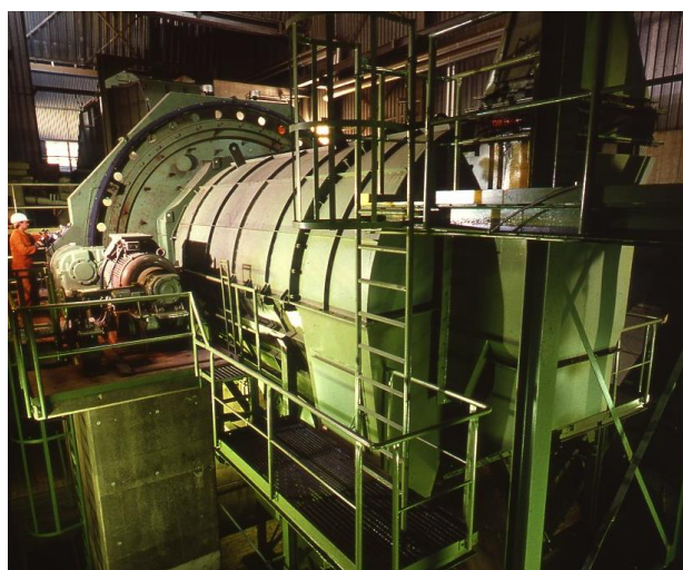
Abb.: ehemalige Kugelmühle
