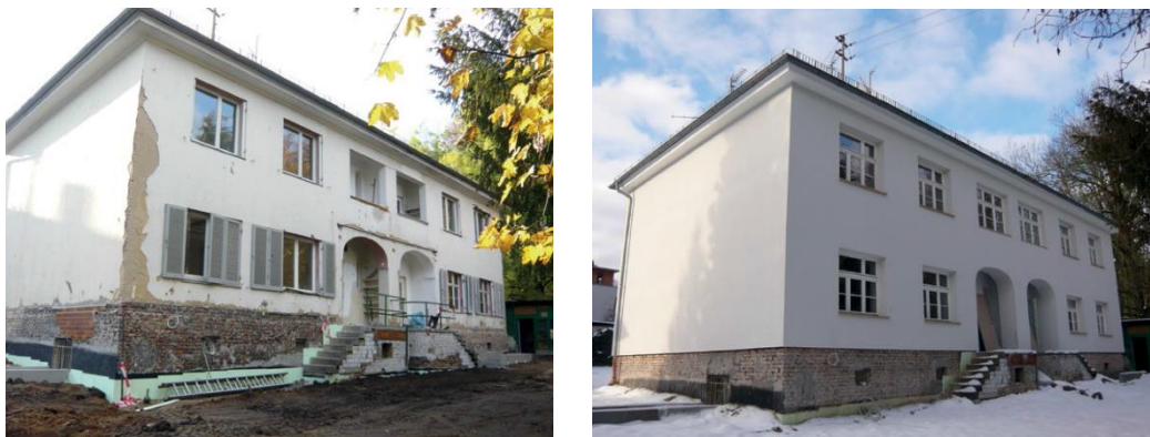
Abbildung 19: Praxisbeispiel 2 Außendämmung mit WDVS, wenig Zierelemente (links: vor der Dämmung, rechts: nach der Dämmung) (Bild: Wiesbaden – Umweltamt 2015, S. 64)
