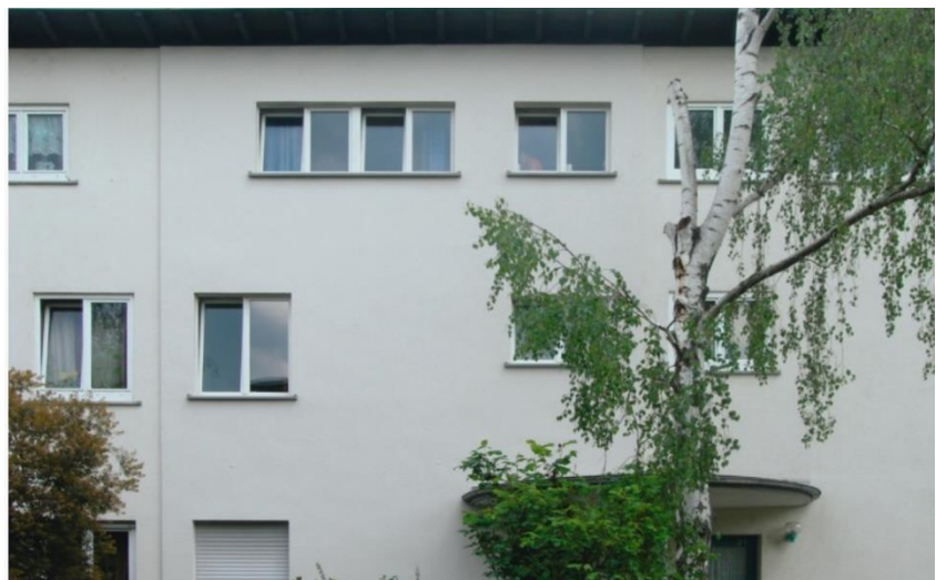
Abbildung 18: Praxisbeispiel Außendämmung mit VIP im Denkmalschutz ohne Bauzier nach Modernisierung (Bild: Skär 2011)
