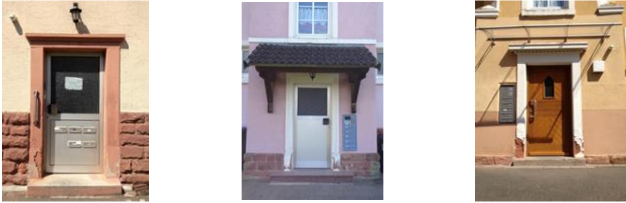
Abbildung 4: Außentüren im Bahnheim (eigene Darstellung)
