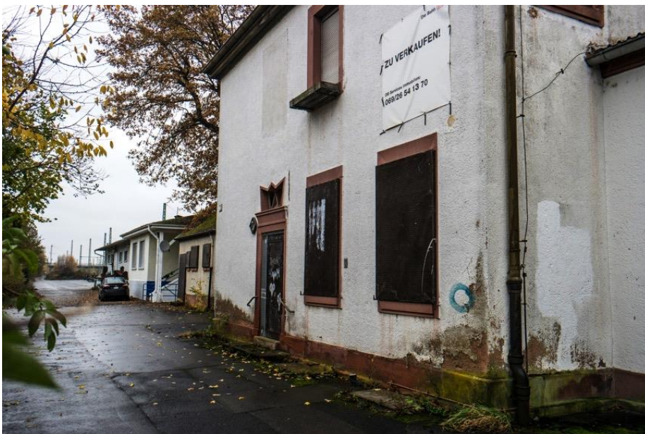
Abbildung 47: Das Bahnhofsbauwerk. Quelle: Eigene Aufnahme.
