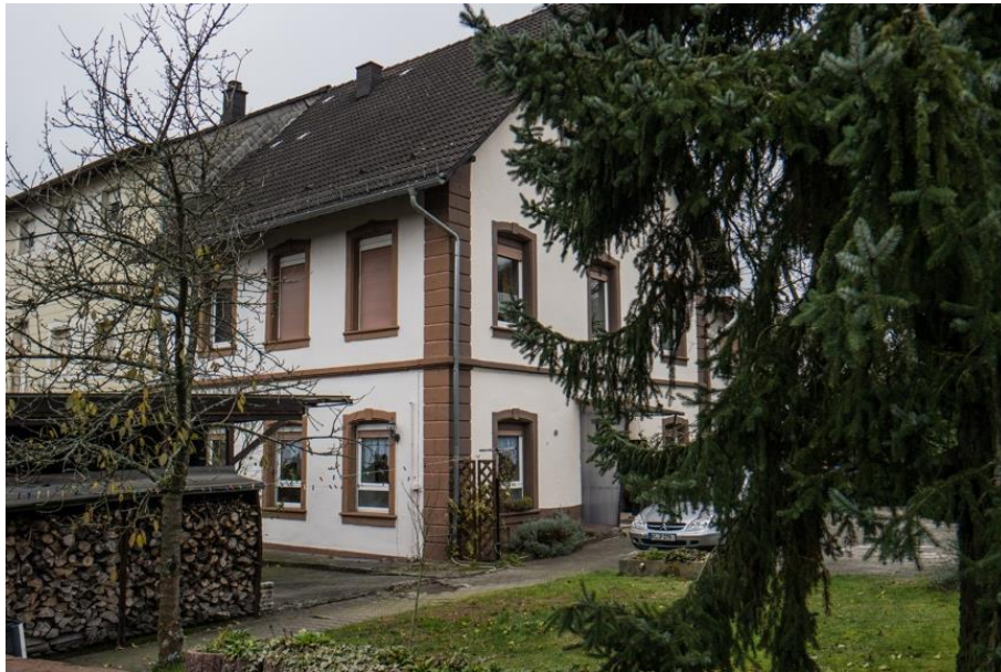
Abbildung 35: Ortsbildprägendes Gebäude an der Kaiserstraße. Quelle: Eigene Aufnahme.
