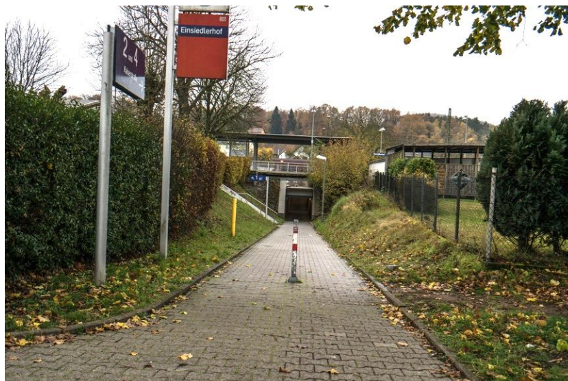
Abbildung 31: Unterführung von der Weilerbacher Straße aus betrachtet und Zugang zu den Gleisen Quelle Eigene Aufnahme.
