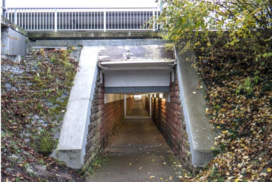
Abbildung 46: Die Unterführung. Quelle: Eigene Aufnahme.
