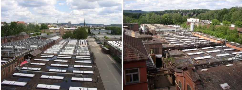
Fotos: Vogelperspektiven auf die Dachlandschaft des „Pfaffgeländes“
